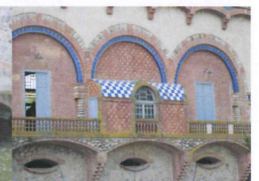
Detalls en façana
