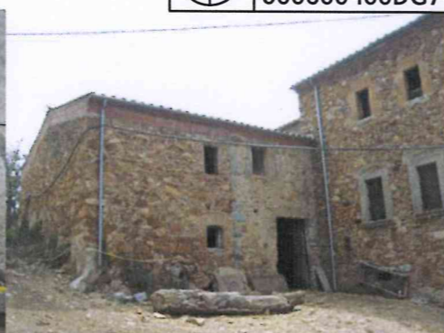
Masoveria façana oest
