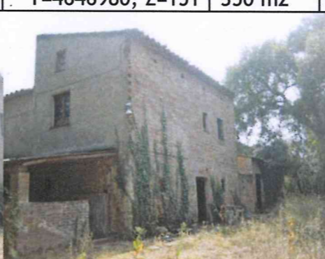
Façana nord i est
