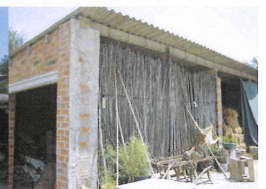
Coberts a la part nord
